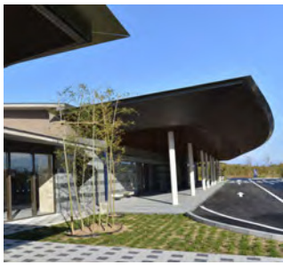
写真3: 屋根軒庇先端
