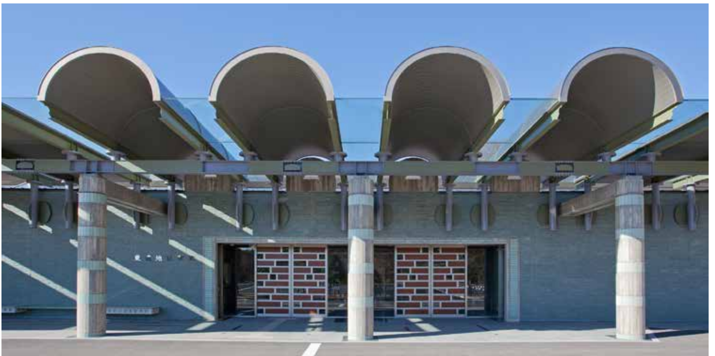
写真3：玄関キャノピー：玄関正面
