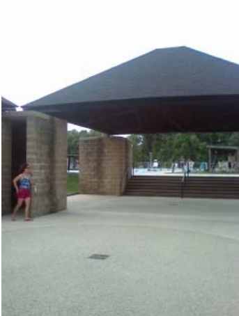
写真2 トレトン・バスハウス 外観
