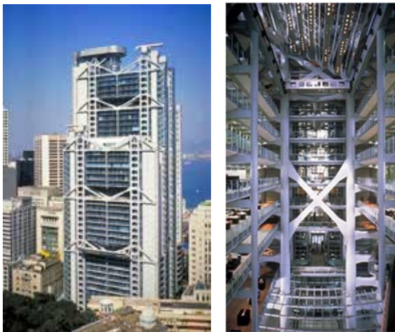
写真9 香港銀行ビル 外観（左）、内観吹抜け（右）
