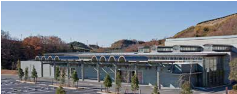
写真4: 玄関キャノピー全景
