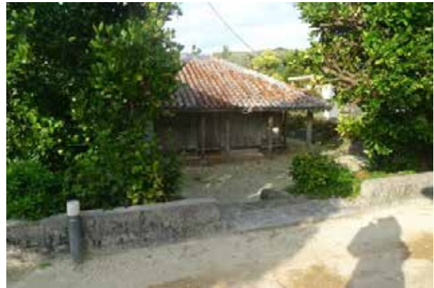
図 1 沖縄県渡名喜島の敷地が掘り下げられた住宅
