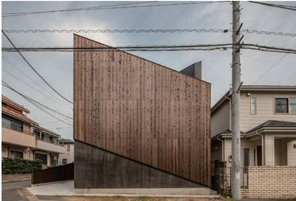
交通量の多い道路側ファサード
