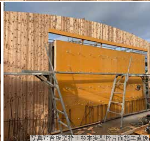
写真7: 合板型枠+杉本実型枠片面施工直後
