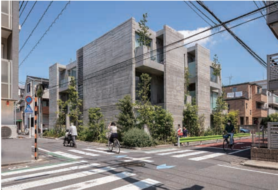
交差点に新たな風景を生み出している
