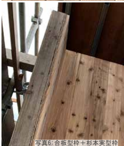
写真6: 合板型枠+杉本実型枠
