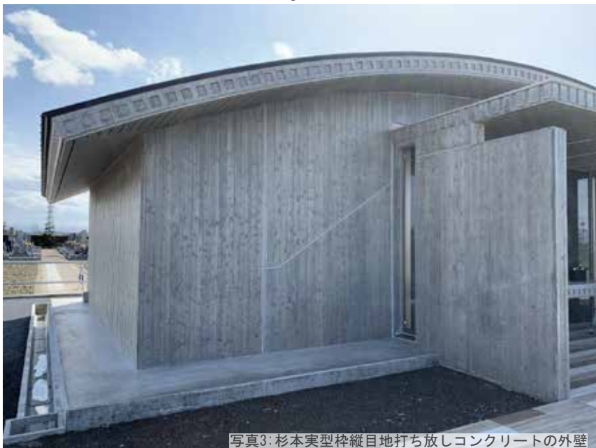
写真3: 杉本実型枠縦目地打ち放しコンクリートの外壁
